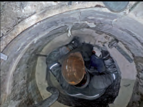
Ausbruch und Identifizierung von Metallzungen
