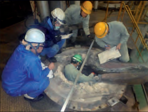
Ausbruch des Feuerfestmaterials mit dem Kunden, Ermittlung der Verschleißursache
