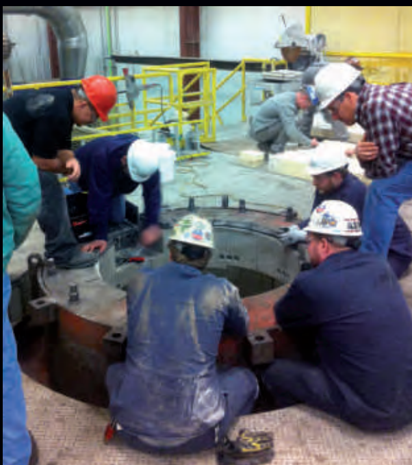
Technische Schulung: Installation der SAVEWAY® Sensoren/Elektrodenplatten mit dem Kunden
