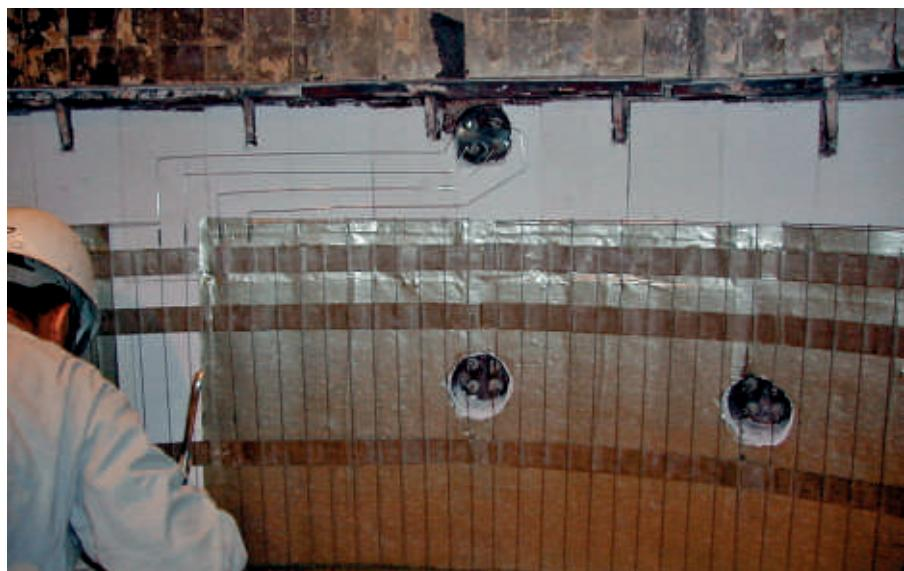
▲ Установка электродных пластин в RH агрегате
